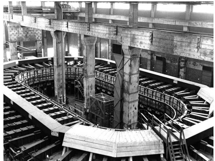
Usine de séparation électromagnétique Y12 (Oak Ridge)
