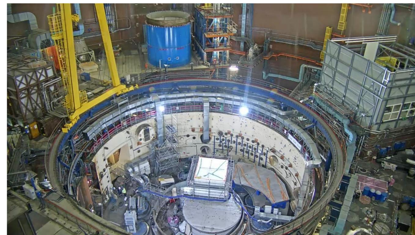
Vue de l'intérieur du bâtiment réacteur en mai 2021. On distingue au centre de la cuve le sas de découpe du dernier bouchon de la cuve ( voir article page 2) ©EDF- Creys
